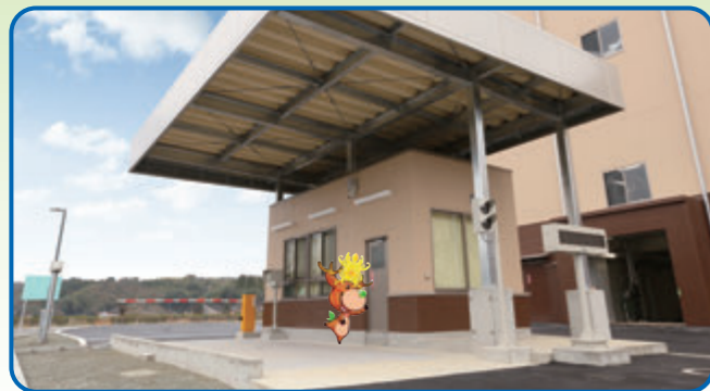
1 計量機 収集されたごみの重さをはかるんだ。
