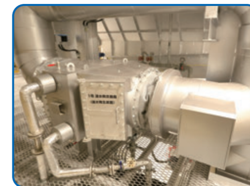
9 温水熱交換器 ごみを燃やすことで発生する高温の熱を回収し、温水をつくるんだ。
