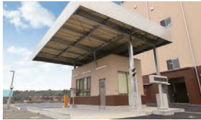
① 計量機 収集されたごみは入場時に自動的に計量・記録し、集中管理します。
