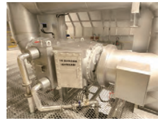
⑦ 空気予熱器 排ガスから熱回収し、焼却用空気を加熱するとともに温水熱交換器へ温風を送ります。
