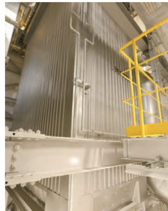
⑧ ろ過式集じん器 排ガスに消石灰と活性炭を吹き込んでろ過し、排ガス中に含まれる硫酸化物、塩化水素、ダイオキシン類、ばいじん等の有害物質を取り除きます。
