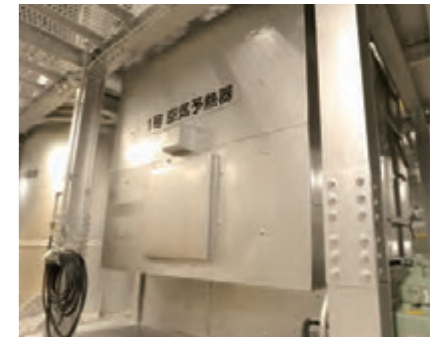
⑦ 空気予熱器 排ガスから熱回収し、焼却用空気を加熱するとともに温水熱交換器へ温風を送ります。
