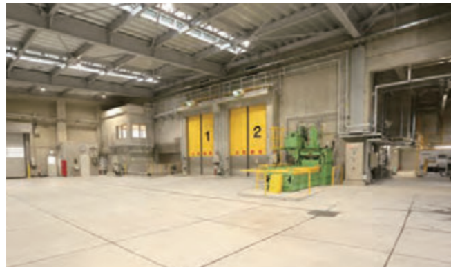
② プラットホーム 自家用車等で持ち込まれたごみは、ダンピングボックス内に荷下ろすことで安全にごみピットへ投入することができます。
